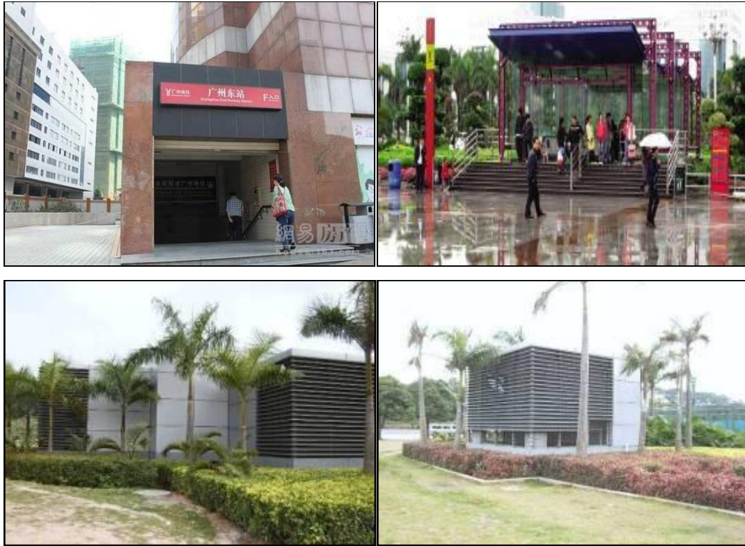
图 4.7-1 地铁出入口、风亭景观
