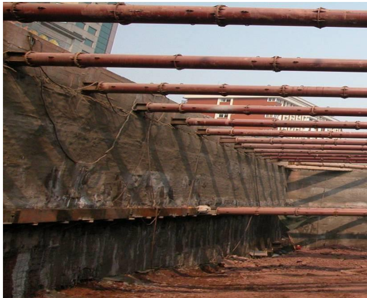
图 4.4-3 钻孔灌注桩法示意图
