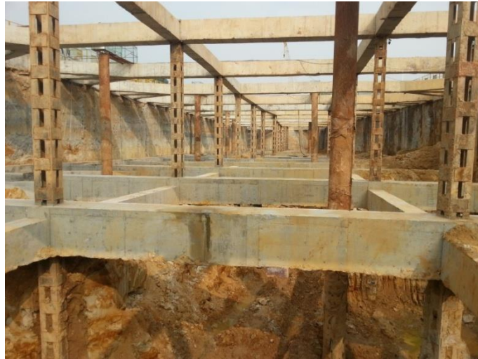
图 4.4-4 地下连续墙围护施工现场
