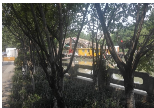
欢喜永宁桥（在修复中）
