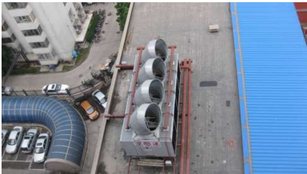
图 4.5-1 冷却塔导向消声器实施实例
