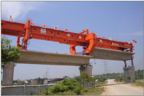
整孔预制吊装施工
