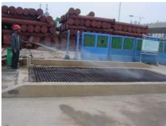
图 10.11-2 4 号线一期工程岳家嘴工点运输车辆清洗槽
