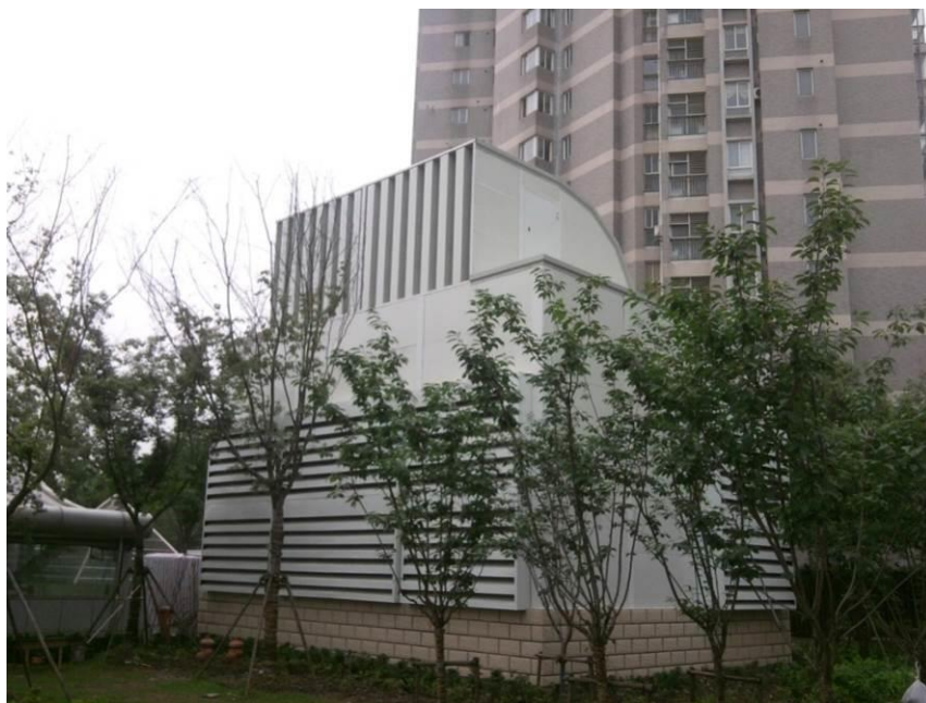
图 4.5-2 冷却塔设置百叶围栏实施实例
