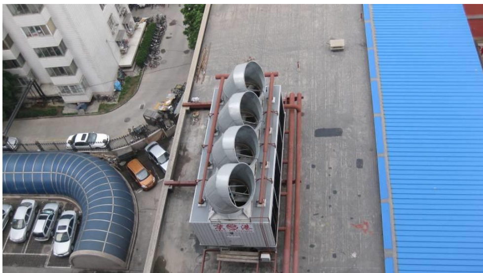
图 4.5-1 冷却塔导向消声器实施实例
