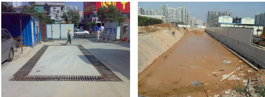
图 7.1-2 施工场地车辆清洗设备及泥浆干化池
