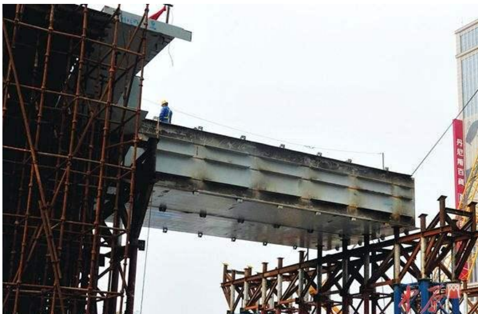
图 2.3.2-1 节段预制拼装技术在工程的应用
