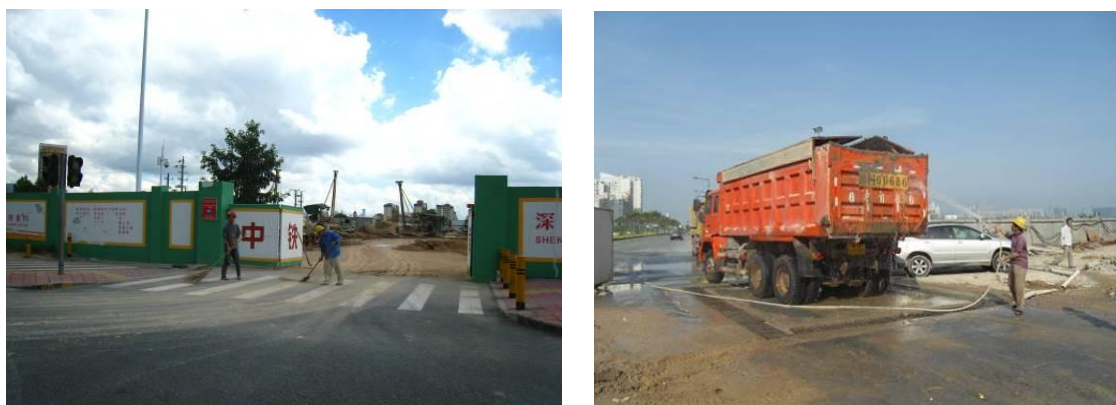
图 7.1-3 施工场地清扫和车辆清洗
