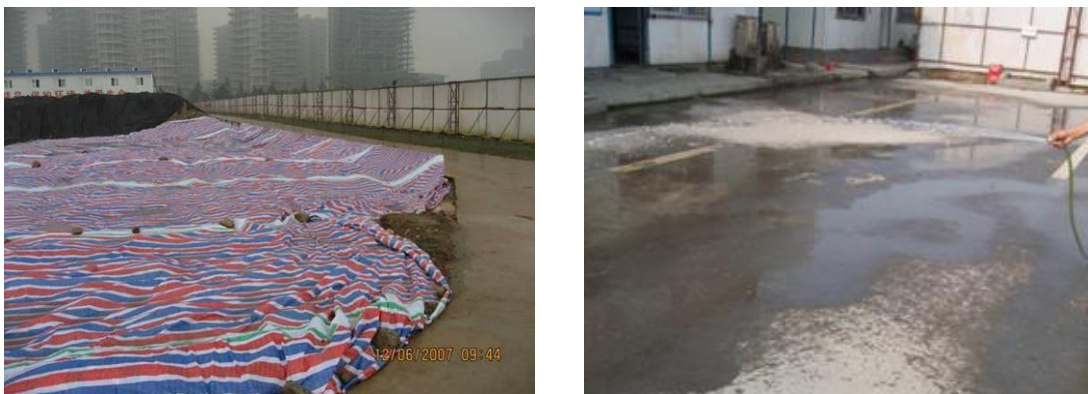
图 7.1-3 施工场地渣土覆盖和冲洗
