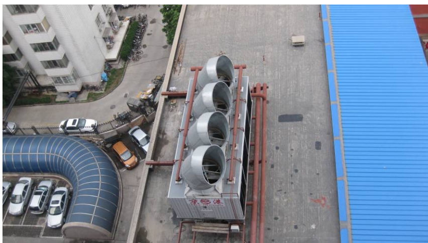
图 4.5-1 冷却塔导向消声器实施实例
