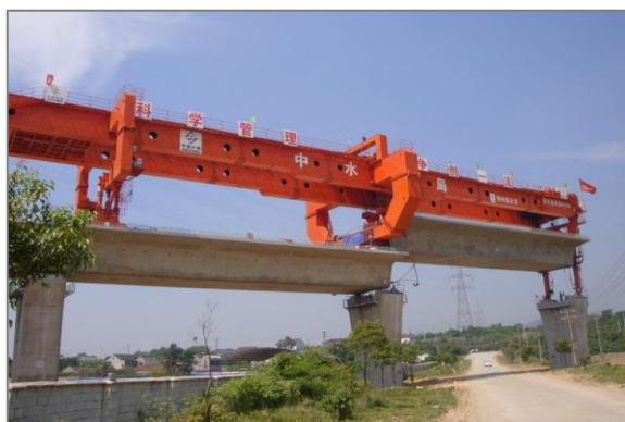
整孔预制吊装施工
