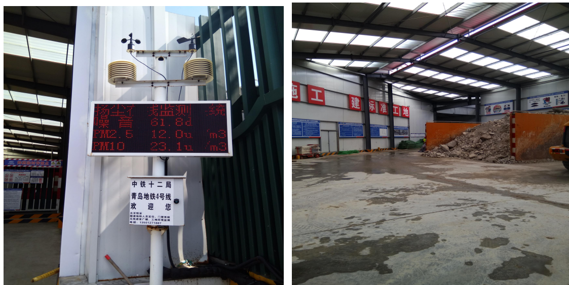
图 11.1-1 在建青岛地铁施工期施工临时工棚
