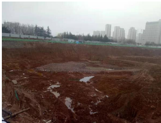
院士港在建建筑
