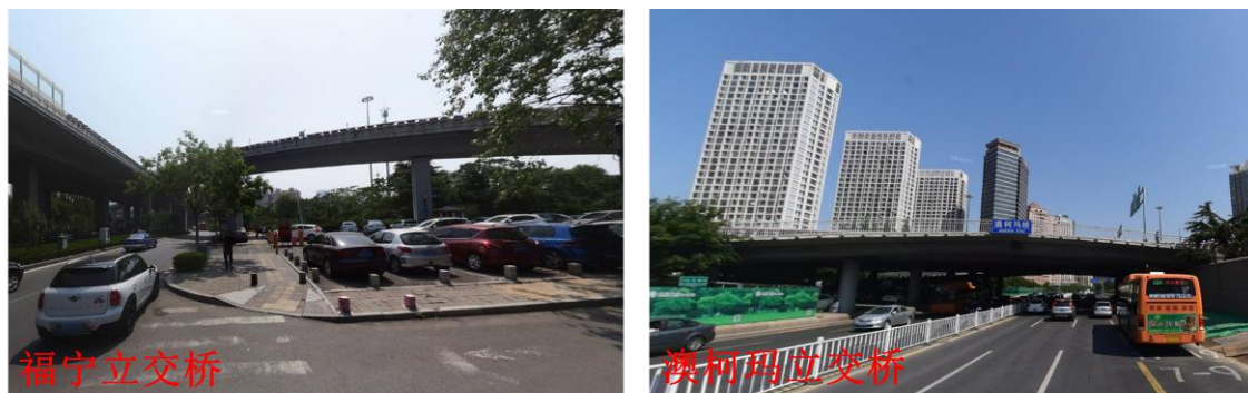
图 2.1-7 福宁立交站~澳柯玛桥站段沿线沿线现状
