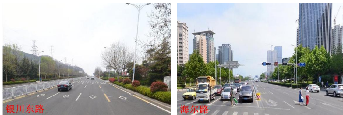
图 2.1-32 国信体育馆站~云岭路站段沿线现状
