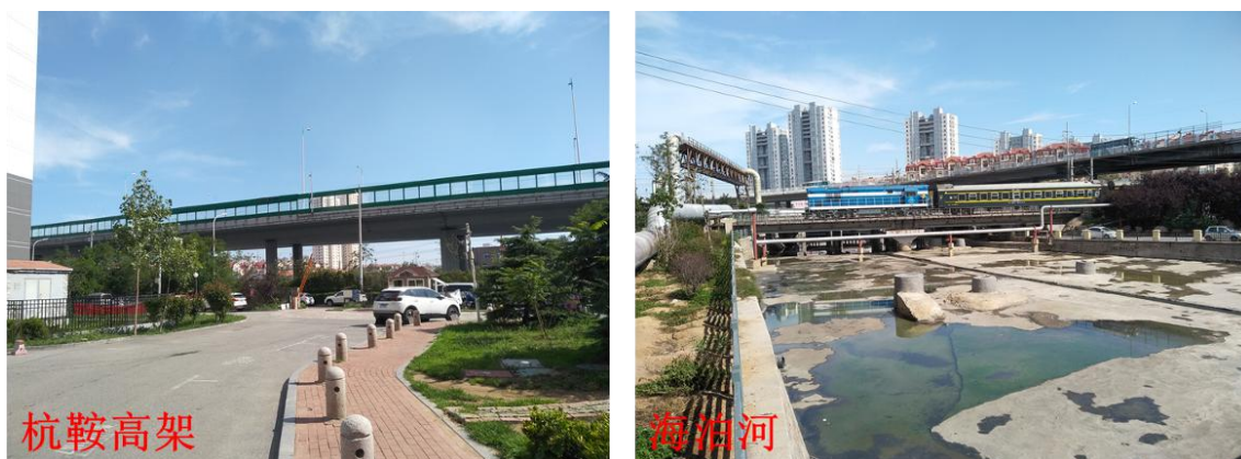
图 2.1-13 昌乐路站~瑞昌路站段沿线现状
