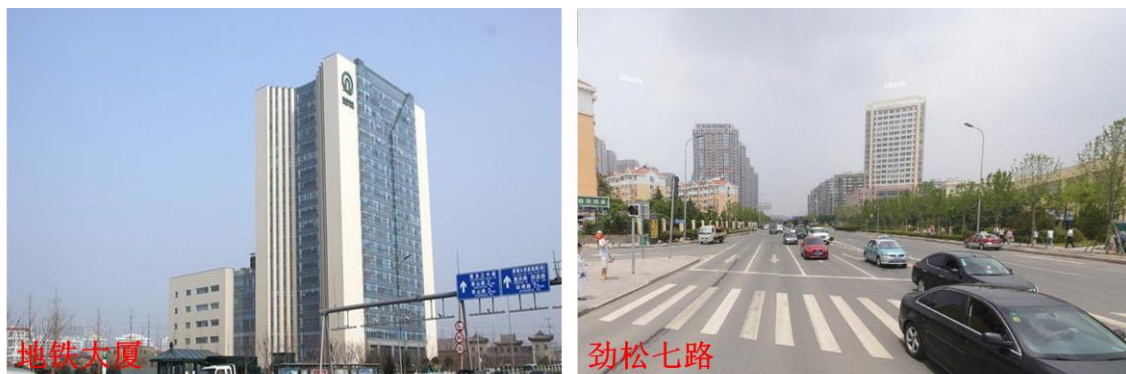
图 2.1-26 地铁大厦站~合肥路站段沿线现状
