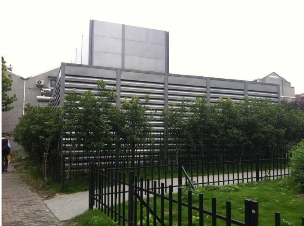
图 5.1-2 冷却塔安装隔音罩实施实例（上海 9 号线小南门站）
