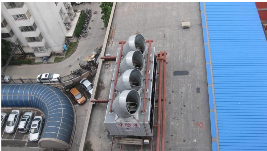
图 5.1-1 冷却塔导向消声器实施实例
