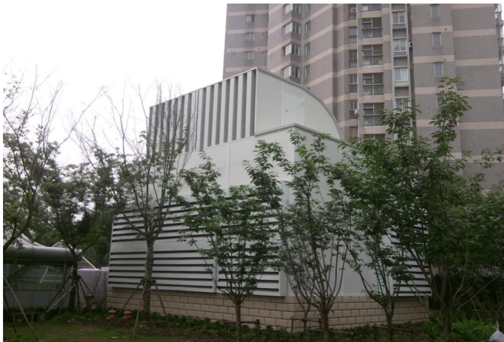
图 5.1-3 冷却塔设置消声百叶围栏实施实例
