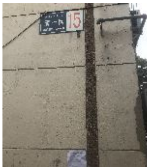
管道小区南1区
