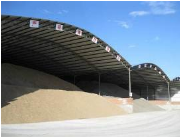
拌合站中砂、碎石密闭存放
