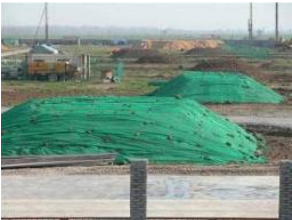
大临工程剥离表土苫盖
