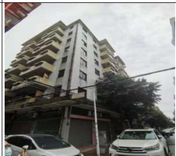
下穿江华社区居民楼 2 现状
