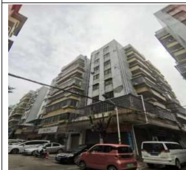
下穿江华社区居民楼 1 现状
