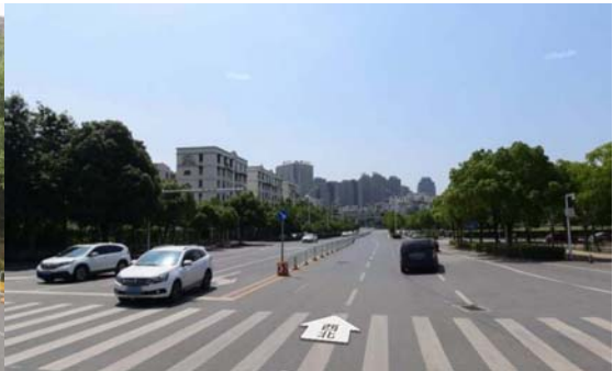
车城西路现状照片
