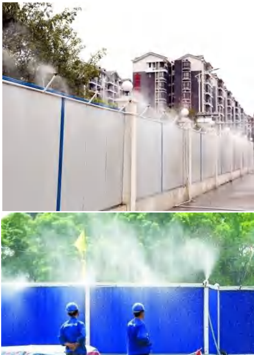
图 4.6-3 施工场地围挡及自动喷淋系统
