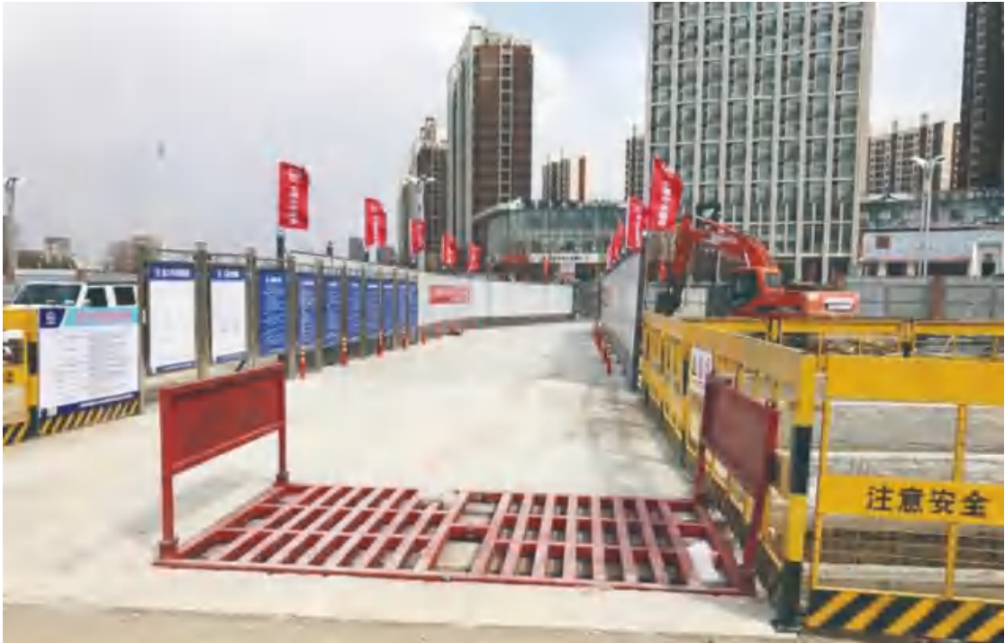
图 4.6-4 施工场地硬化及截排水沟
