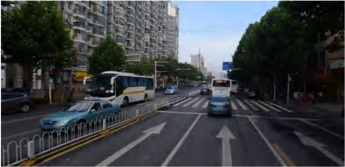
图 1.11-1 二七路（建设大道-解放大道）现状
